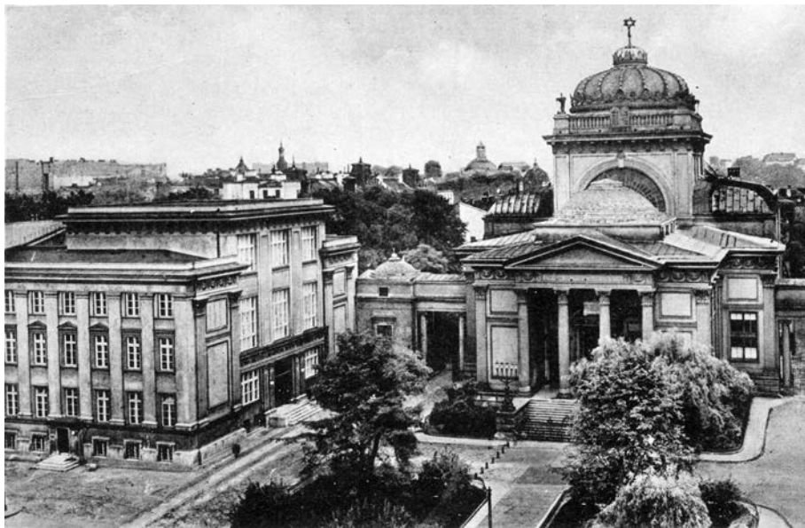
Wielka Synagoga na Tłomackiem i Centralna Biblioteka Judaistyczna, 1936–1939
